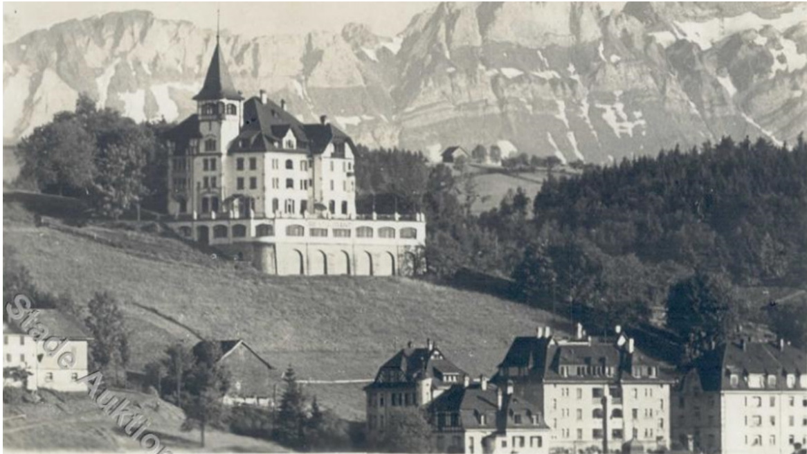
Ehem. Rest. Scheffelstein, Obere Berneggstr. 66, 9012 St. Gallen
